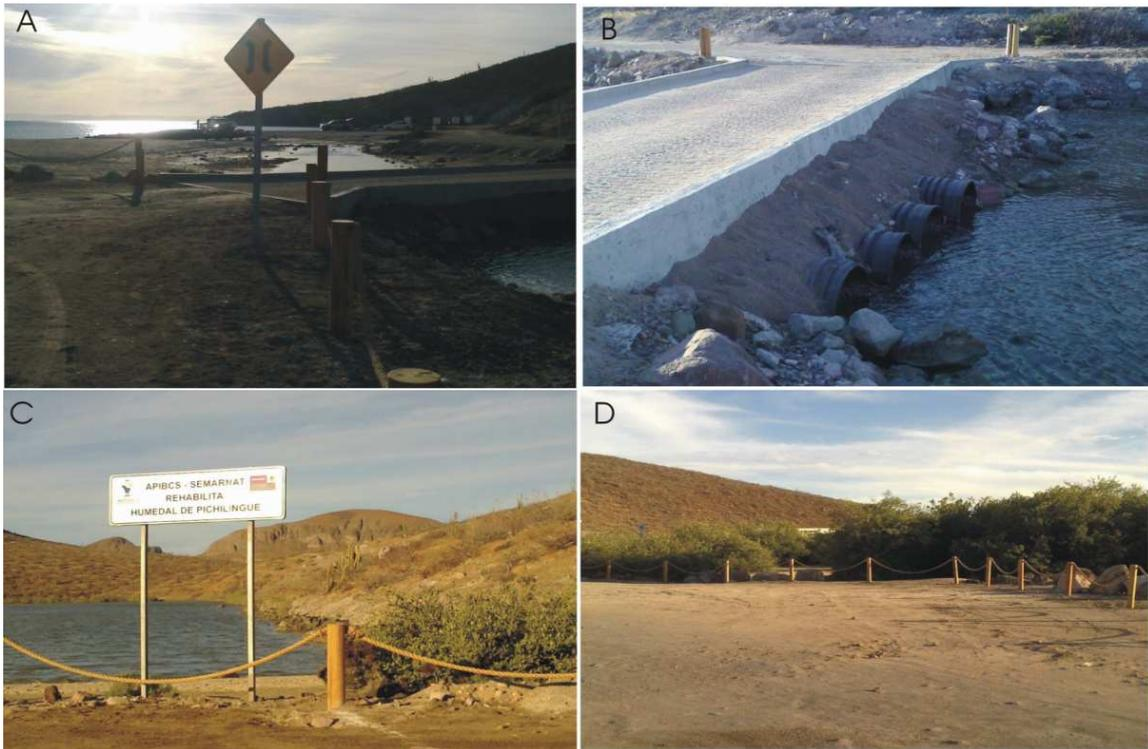
**Fig. 85.-** Playa Pichilingue. A y B.- Se observa un nuevo puente y la instalación de tubos de PVC para la entrada del agua de mar hacia la laguna. C.- Al fondo se observa la laguna y el letrero donde indica que se ha rehabilitado el manglar. D.- Se instaló una pequeña cerca de madera y mecate, para prohibir el paso hacia el manglar.
